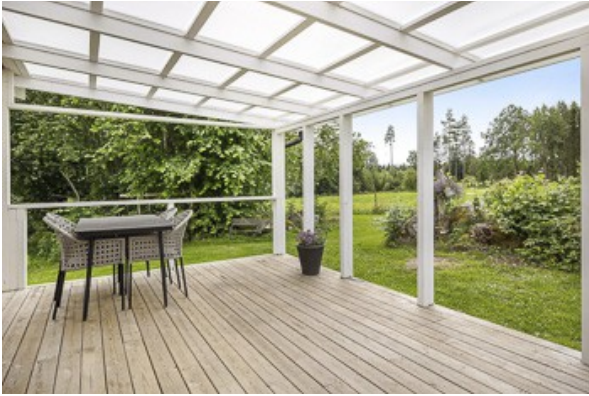
auf der überdachten Veranda an der Giebelseite
