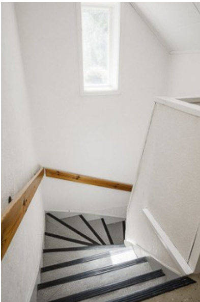
Treppe in das DG
