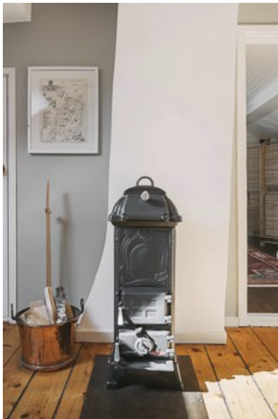
Kaminofen im Flur DG
