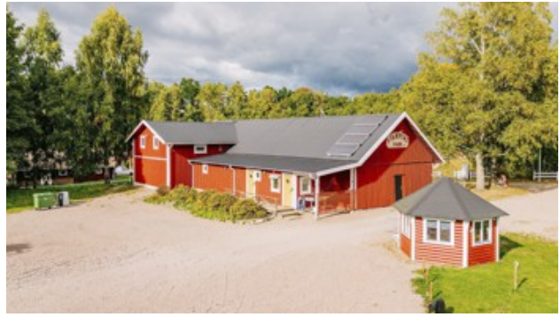
Blick auf die umgebaute Scheune
