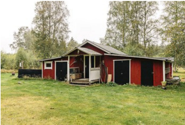
Nebengebäude mit Vorratsräumen und Waschküche
