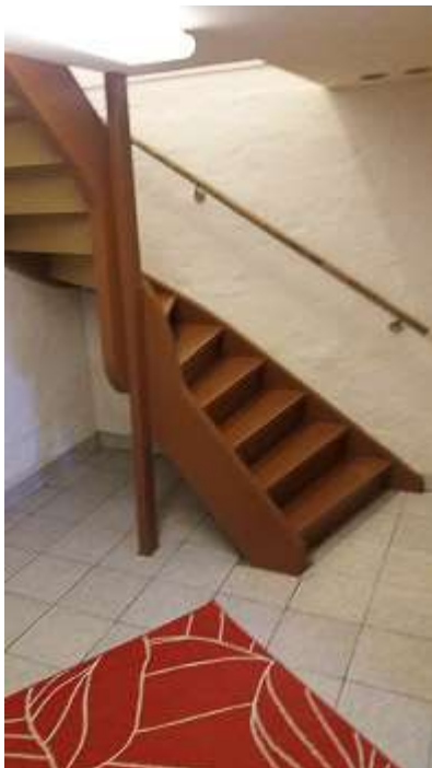
Treppe in das KG
