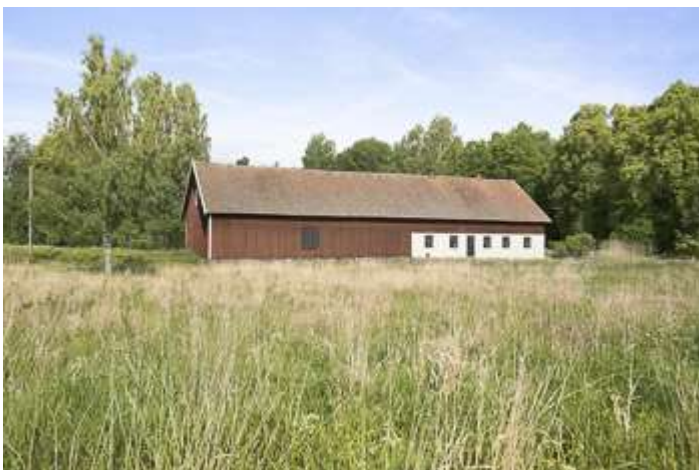
Blick auf die Scheune
