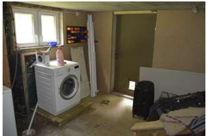
Blick in den Keller
