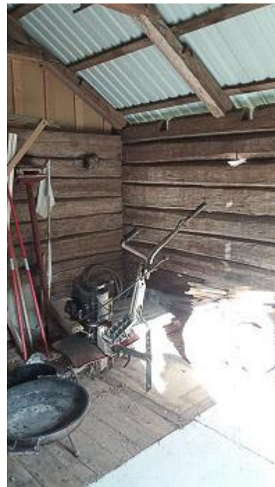
Blick in das Nebengebäude
