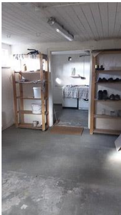
Blick in den Vorratskeller
