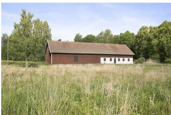
Blick auf die Scheune
